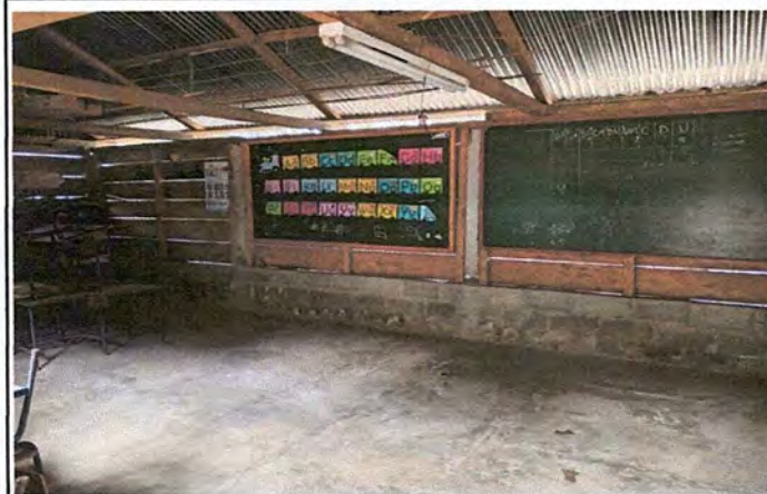
Foto 3: Mejoramiento de aula tipo pórtico
