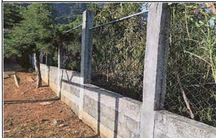
Foto 4: Mejoramiento de cerco perimetral
