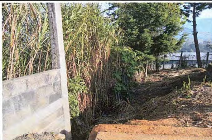
Foto 3: Mejoramiento de cerco perimetral
