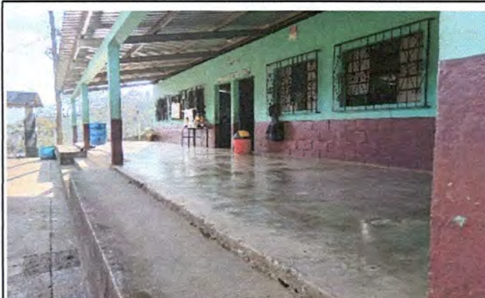
Foto 2: Mejoramiento de loza de patio
