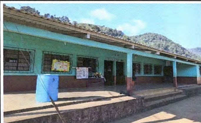
Foto 1: Mejoramiento de loza de patio
