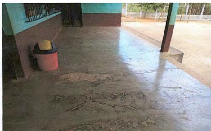
Foto 3: Mejoramiento de loza de patio
