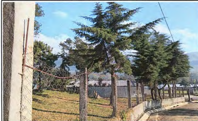
Foto 2: Mejoramiento de cerco perimetral
