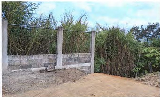
Foto 1: Mejoramiento de cerco perimetral
