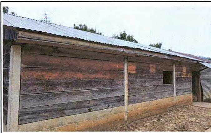
Foto 2: Mejoramiento de aula tipo pórtico
